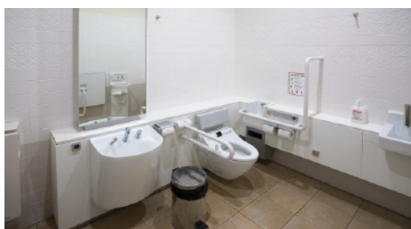
トイレ、汚物処理室
